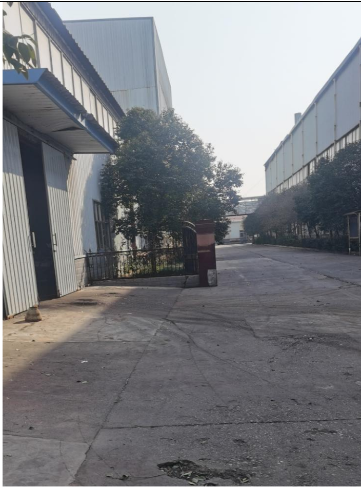
车间南侧道路
