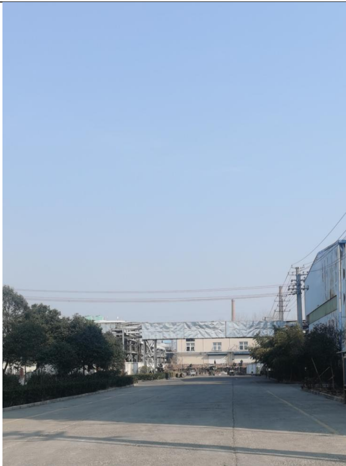
车间西侧道路
