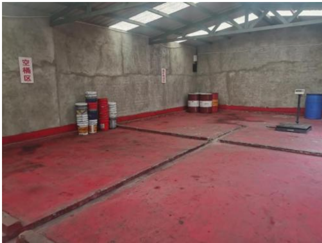
厂区危废暂存间内部
