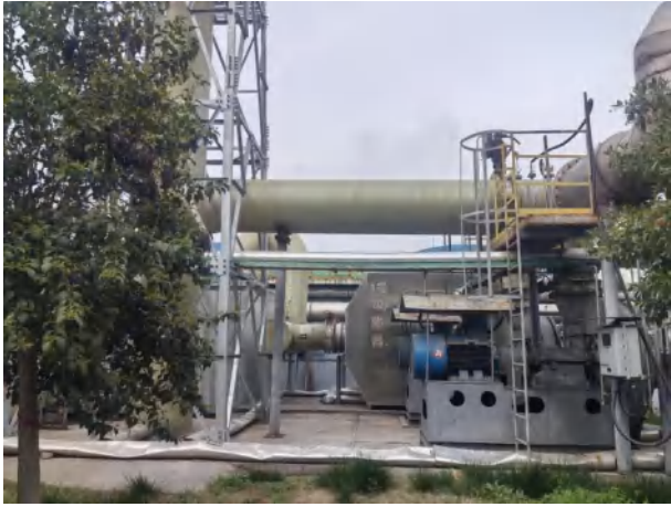
厂区污水处理站除臭生物除臭塔及活性炭装置
